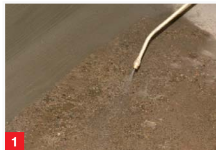
1 Kiesol påføres med lavtrykssprøjte
