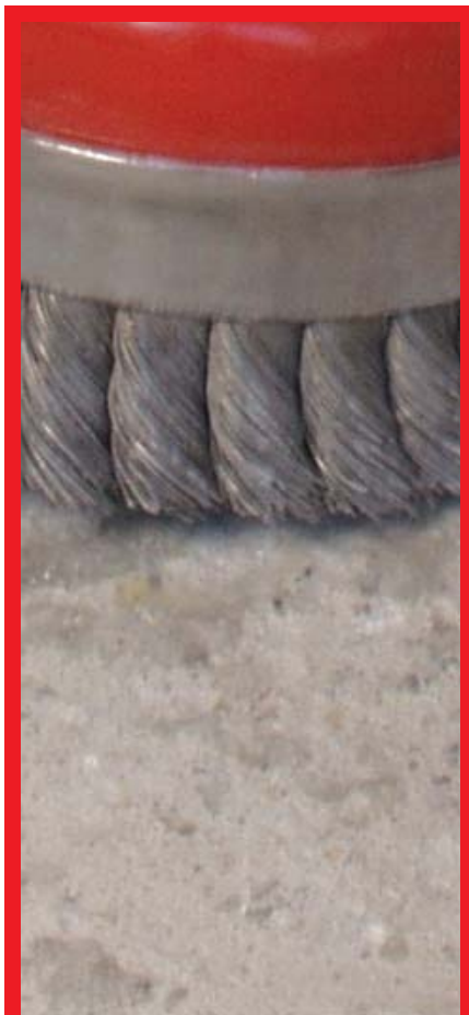
Systematisk afrensning af beton og slidlag for at fjerne løst malingsrester.
