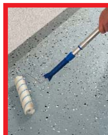
Efter toplaget er tørret (mindst 12 timer ved 20° C), forsegles gulvfladen med EpoxyFlex Transparent .
