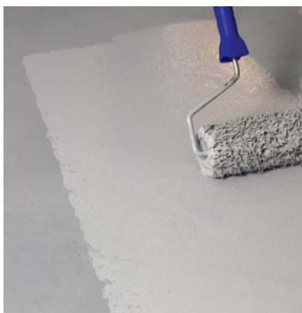
Påfør top lag BS 3000 på den grundede overflade.
