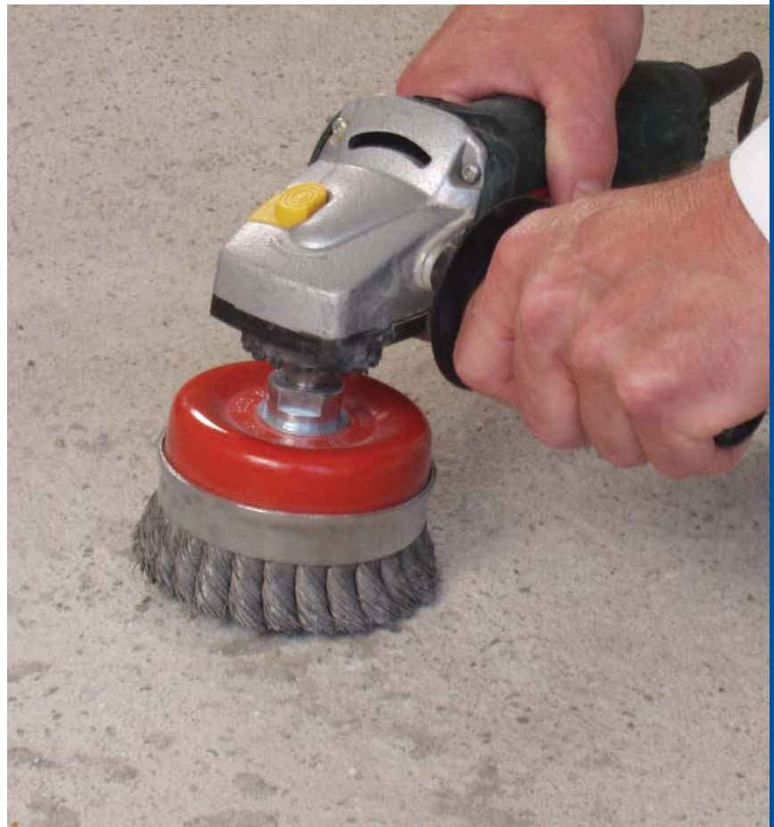
Roterende sliberondeler anbefales til afrensning af mindre flader i eks. garager, trapper, altaner, mv. For større arealer kræves kraftigere slibemaskiner.
