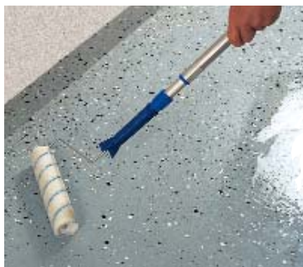
Efter fuld tøring forsegles med Epoxyflex Transparent .
