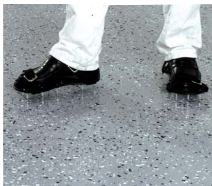
Mønster-flager drysses udover gulvfladen.
