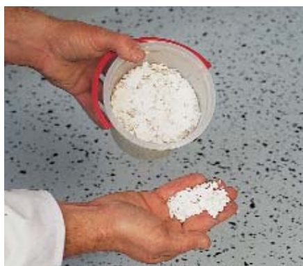
Mindre gulvflader opdeles i sektioner, og Mønsterflager uddrysses...
