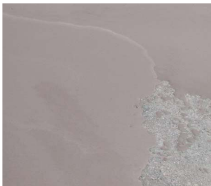
Udjævn gulvoverfladen med Selv-nivellering .
